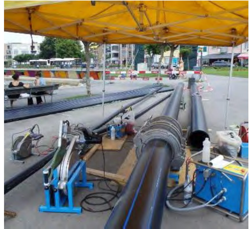
■ Schweissstoss PE-Rohre
