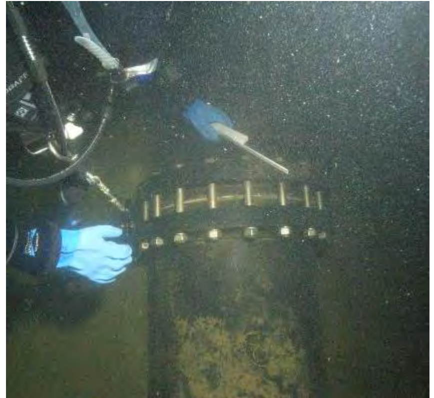
■ Flanschverbindung PE-Rohr
