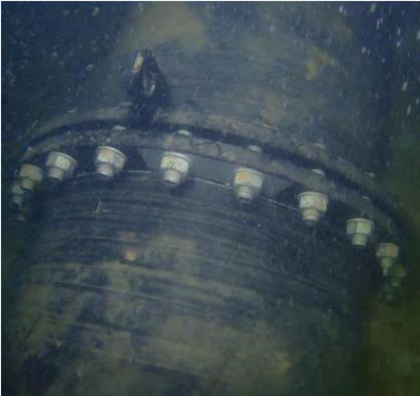
■ Flanschverbindung Stahlrohr
