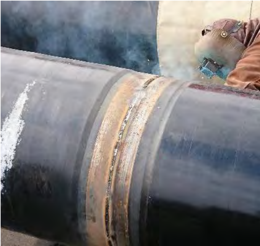
■ Schweissstoss Stahlrohr
